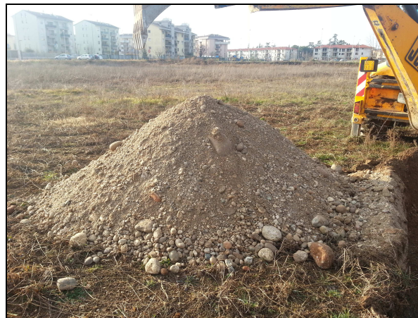
Trincea n.1 - cumulo
