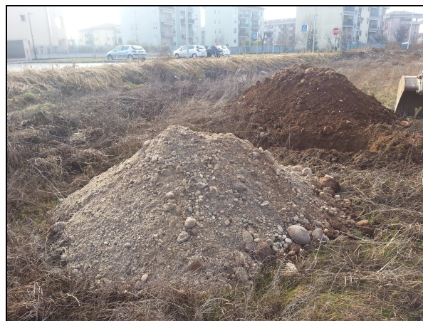
Trincea n.3 - cumulo
