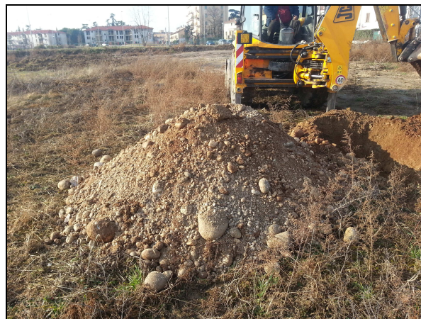
Trincea n.2 - cumulo
